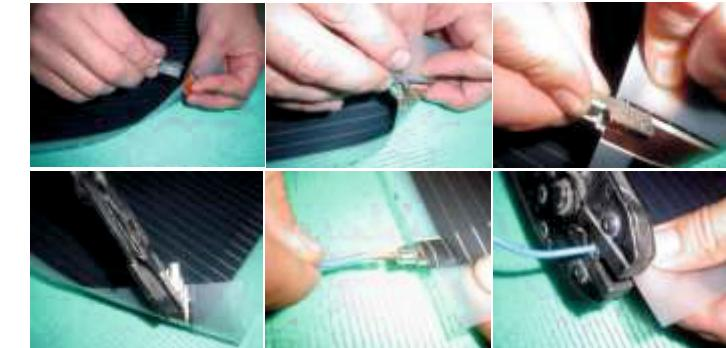
Места соединений, контактные клипсы и незадействованные конечности медных токопроводящих лент тщательным образом изолируются с помощью изоляции, как показано на фотографии. В случае лишней толщины контактной группы в полу или теплоизоляторе под пленкой делаются соответствующие углубления. Провода фиксируются клейкой лентой типа Scotch. Производится монтаж терморегулятора и его соединение с нагревательной пленкой и электропитанием. Проверяется работоспособность подключения.
